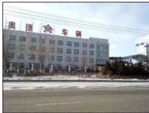
图 3-6 西侧为营口奥捷专用汽车制造有限公司
