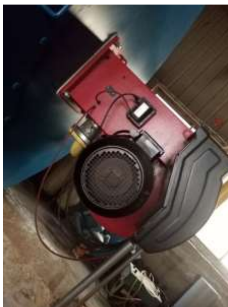
图 4-10 锅炉风机隔声措施照片
