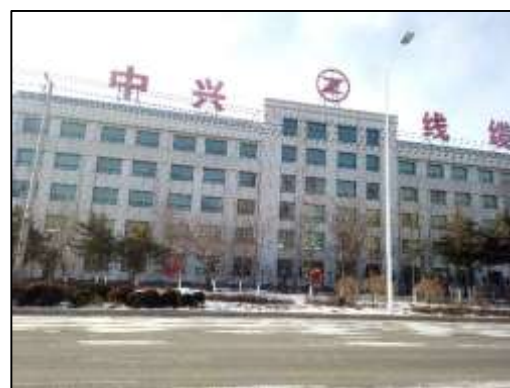
图 3-8 北侧为辽宁中兴线缆有限公司
